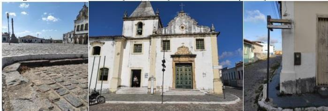
Figura 38 – São Cristóvão/SE: Barreiras para acessibilidade (A) Desnível da calçada; (B) Degraus na entrada da edificação; (C) Calçada estreita e com presença de obstáculo
