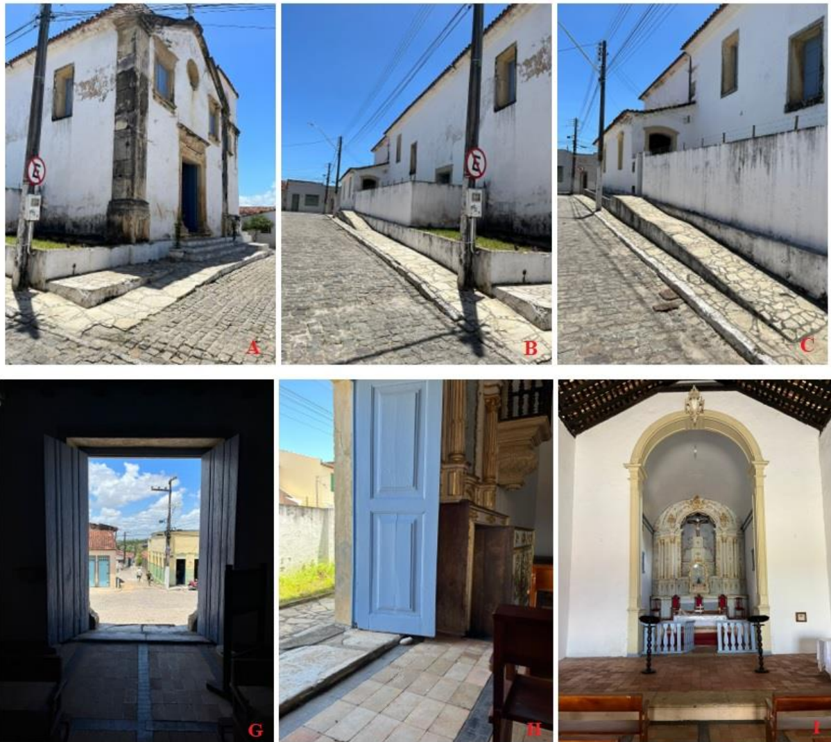
Figura 25 – São Cristóvão/SE: Questões de acessibilidade na Igreja Nossa Senhora do Rosário dos Homens Pretos (A) Degraus na porta; (B) Calçada estreita com rampa; (C) Rampa sem corrimão; (D e E) Desníveis interno; (F) Degrau interno
