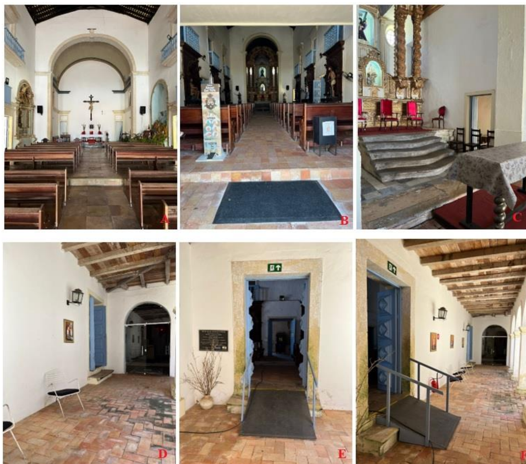
Figura 33 – São Cristóvão/SE: Conjunto do carmo - Questões de acessibilidade no Conjunto do Carmo (A, B, C e D) Degraus no interior da edificação; (E e F) Rampa sem conformidade à NBR 9050/2020
